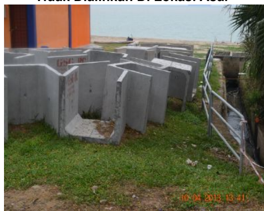
Gambar 1.28 Longkang Konkrit Masih Tidak Dialihkan Di Lokasi Asal
