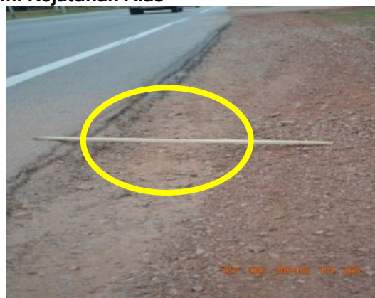
Gambar 1.22 Bahu Jalan Mengalami Kejatuhan Alas
