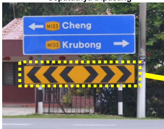
Gambar 1.13 Contoh Chevron Delineator Yang Sepatutnya Dipasang
