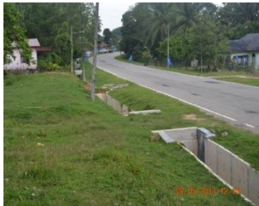
Gambar 1.25 Kerja Menaik Taraf Longkang Telah Dilaksanakan Di Lokasi Baru
