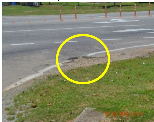
Gambar 1.19 Pavemen Mengalami Kerosakan Tepi
