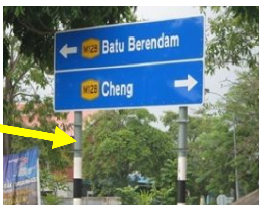
Gambar 1.14 Chevron Delineator Telah Hilang
