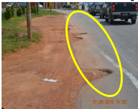
Gambar 1.19 Pavemen Mengalami Kerosakan Tepi
