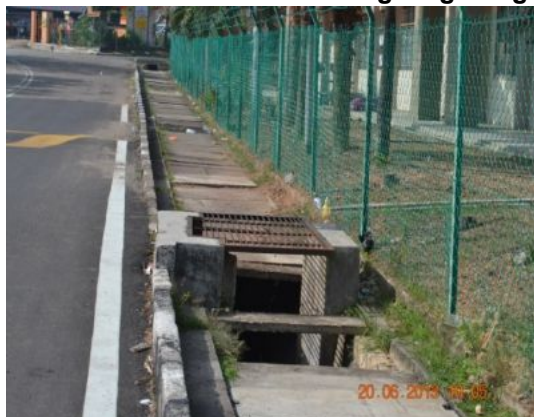
Longkang Yang Tidak Dipasang Slab
