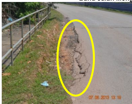
Gambar 1.22 Bahu Jalan Mengalami Kejatuhan Alas
