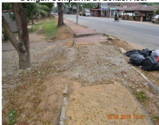
Gambar 1.27 Kesan Korekan Yang Tidak Disenggara Dengan Sempurna Di Lokasi Asal
