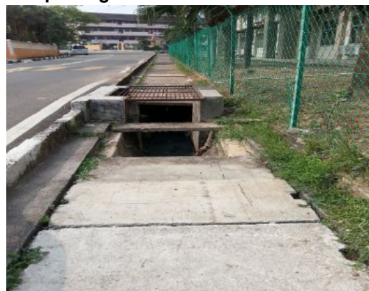
Longkang Yang Tidak Dipasang Slab
